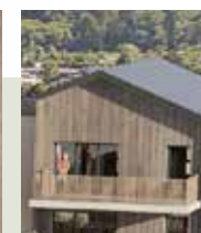
TOITURE À 2 PANS en bac acier
